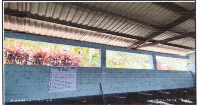
Foto 2: sustitucion de ventanas
